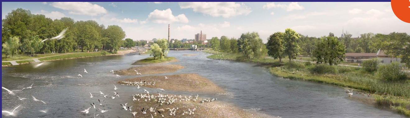
Pohled proti proudu znázorňující rozšíření koryta a nové ostrovy. Původní břeh probíhá přibližně po levé hraně nových ostrovů.
